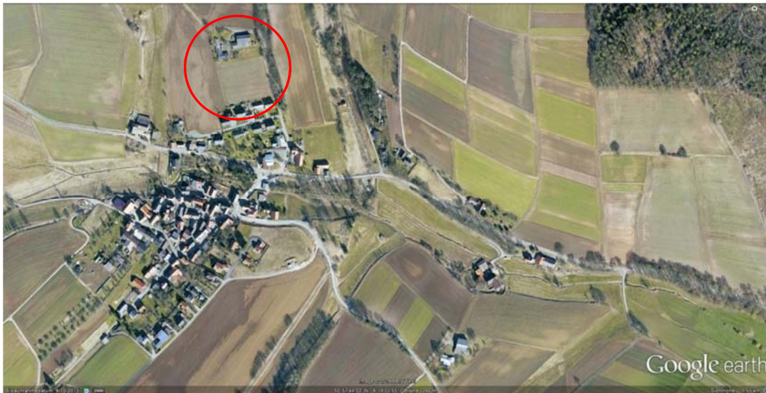
Ausschnitt Luftbild mit der Ortslage Elnrode (Gemeinde Jesberg) mit dem Bereich der Planung
