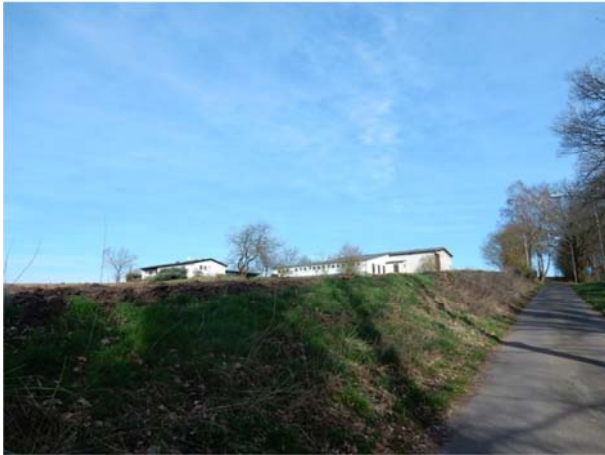
Abb. 4 Blick vom nördlichen Ende des Flst. 318 auf die tiefer gelegene Fernmeldeeinrichtung der Telekom
