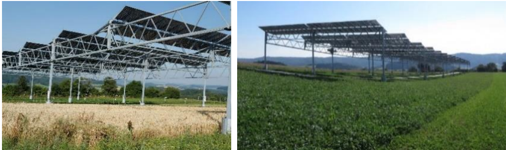
Abbildung 15: Beispiel für Ständerkonstruktion aus der Agri-Photovoltaik
