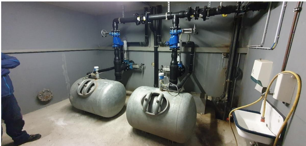
Abbildung 17: PW-Elnode-Strang: Druckbehälter
