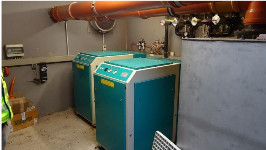
Abbildung 18: PW-Elnrode-Strang: Gebläse 1 und 2
