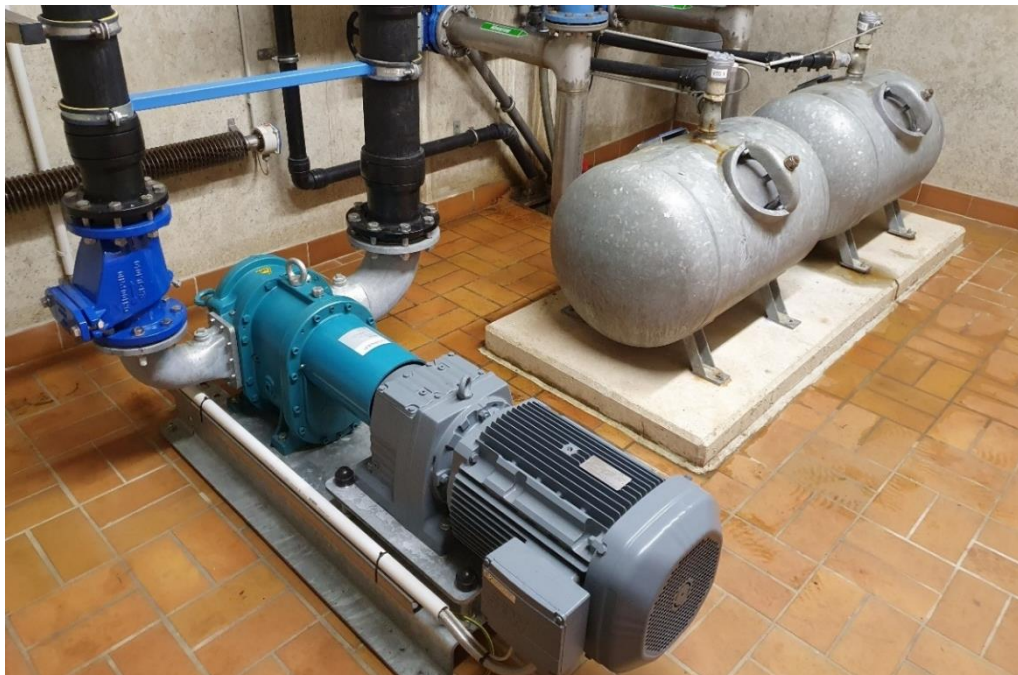
Abbildung 20: Beispiel: Nachrüstung einer Drehkolbenpumpe für die Energieeinsparung.
